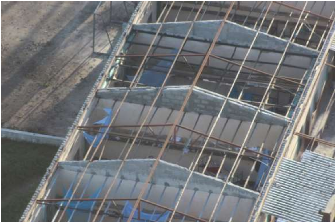
Immagine 4: I tetti delle camerate e scuola di Barada
