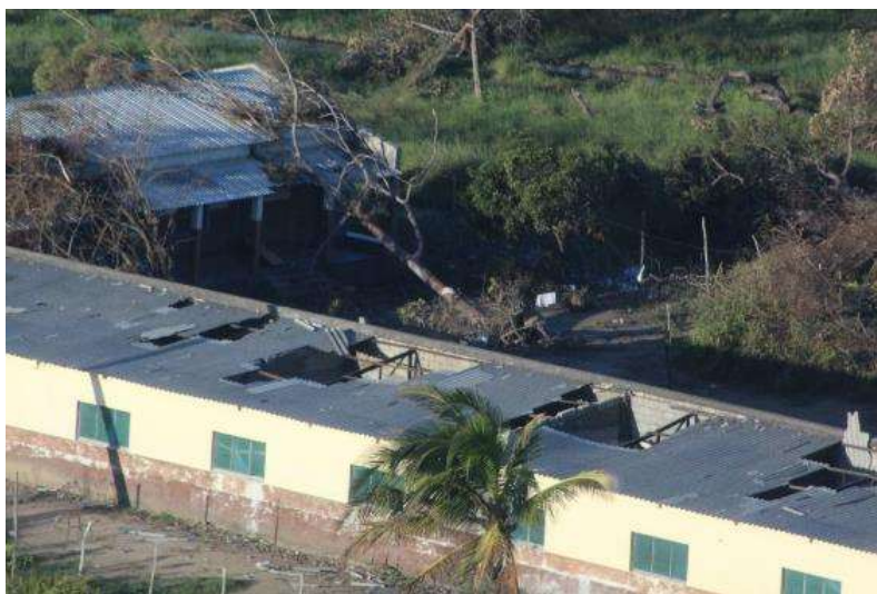
Immagine 1: Distruzione dei tetti e dei controsoffitti nella scuola di Barada
