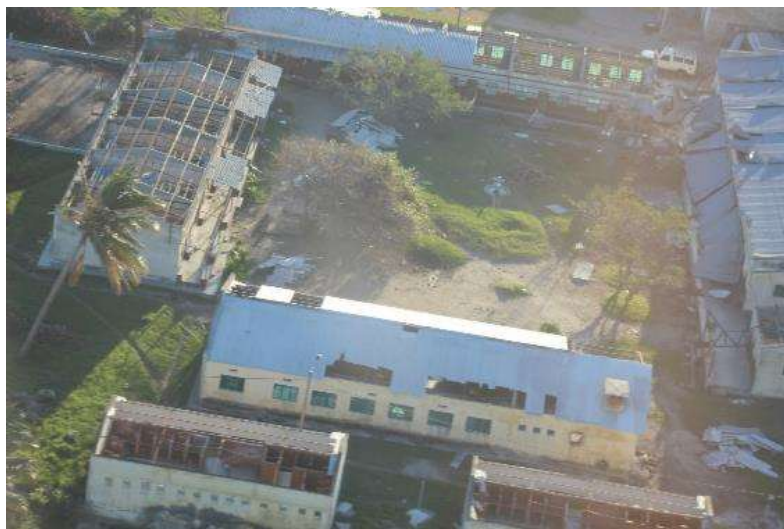
Immagine 2: Gran parte della distruzione è stata causata dal vento molto forte ma anche dalla caduta degli alberi.
